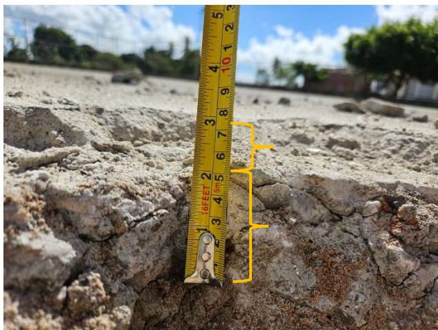
Imagem 2 - Detalhe de Lastro e Cimentado
