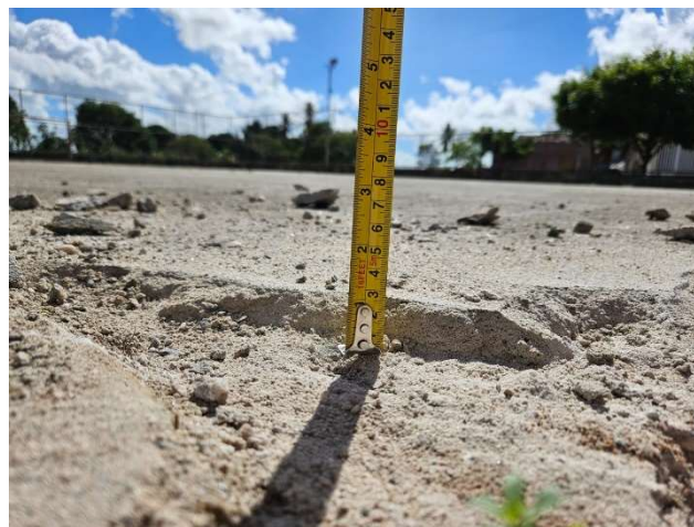
Imagem 3 - Detalhe de Lastro e Cimentado
